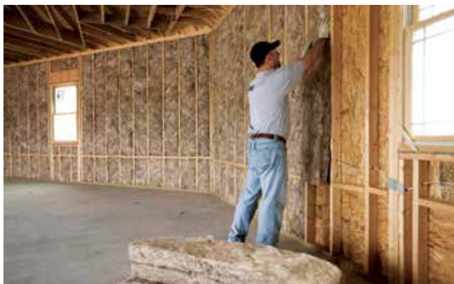
▲ In Deutschland entfällt rund die Hälfte des Endenergieverbrauchs auf die Raumwärme. Hausbauer sollten auf eine gute Dämmung achten. Heating accounts for around half of the endues energy consumption in Germany. Home builders should ensure good insulation.
